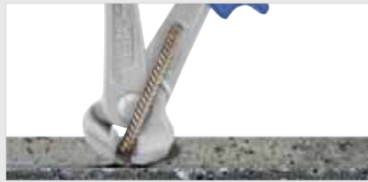
→ Nahezug bündiges, frontales Trennen von Bolzen und Nägeln
