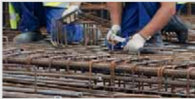
→ Auch geeignet zum Binden (Flechten) und Schneiden von Bindedraht für Monierreisen
